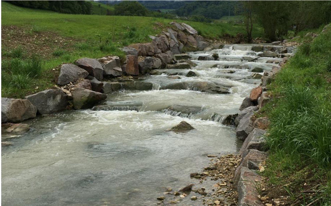
Abb. 5: Verbesserte Längsvernetzung: Ersatz einer Schwelle durch eine fischgängige Blockrampe unterhalb der ARA Frenke 2.
