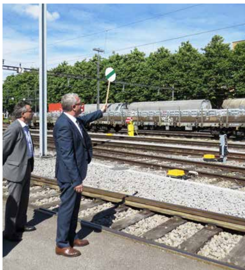
Christoph Brutschin, Regierungsrat des Kantons Basel-Stadt, nimmt das Stellwerk offiziell in Betrieb
