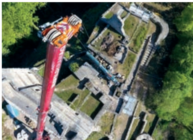
Mit der aktuell laufenden Sanierung der Ruine Farnsburg (2020–2022) wird das dritte Grossprojekt zur Sicherung von Burgen und Ruinen umgesetzt. Das vierte Projekt wird abschliessend den römischen Gutshof von Munzach bei Liestal betreffen.
