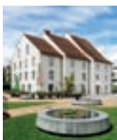
S 111 BINNINGEN IMHOF-HAUS UMBAU: LUKAS BUOL UND MARCO ZÜND
