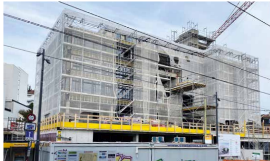
Links: Stand des Umbaus am 8.3.2020
