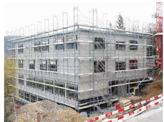
Der praktisch fertige Rohbau mit den ersten eingesetzten Fenstern (Stand 8.3.2020)
