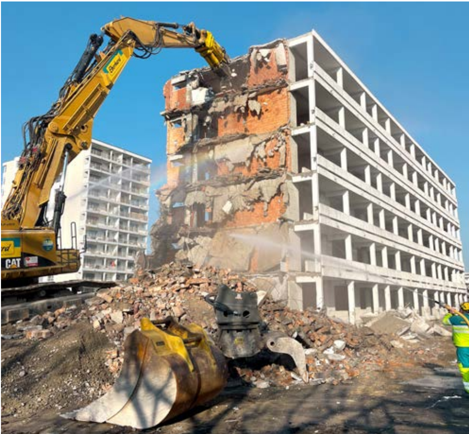
Baustelle in Pratteln
