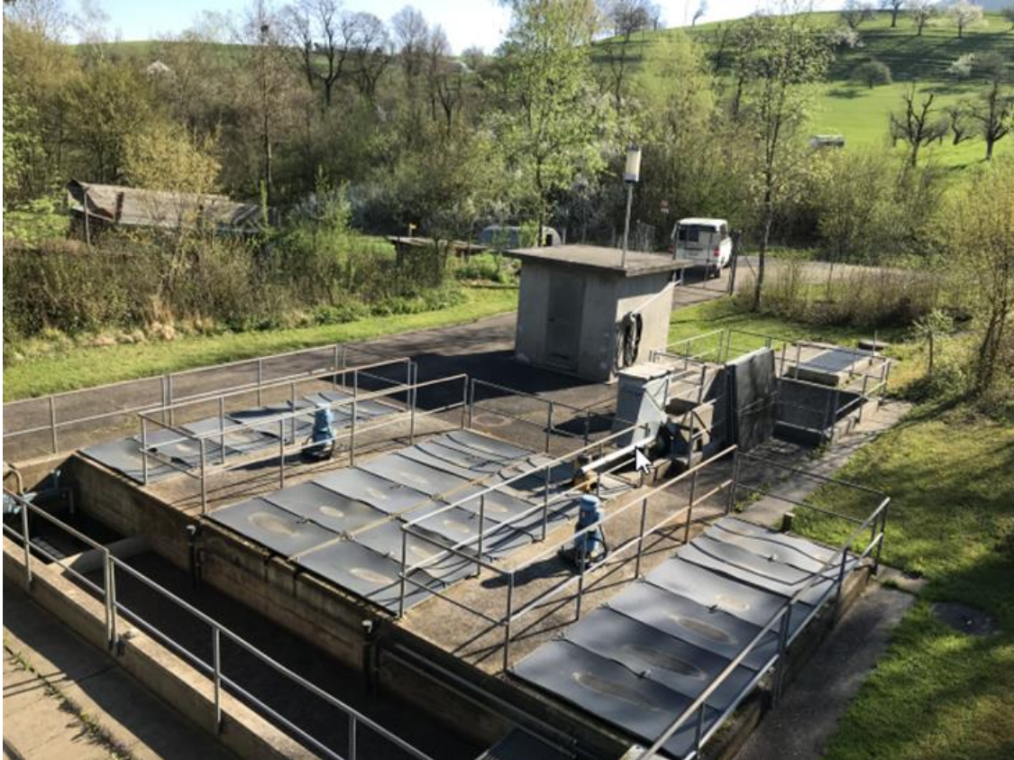
Abbildung 3: ARA Oltingen Baujahr 1974 (Foto April 2018)
