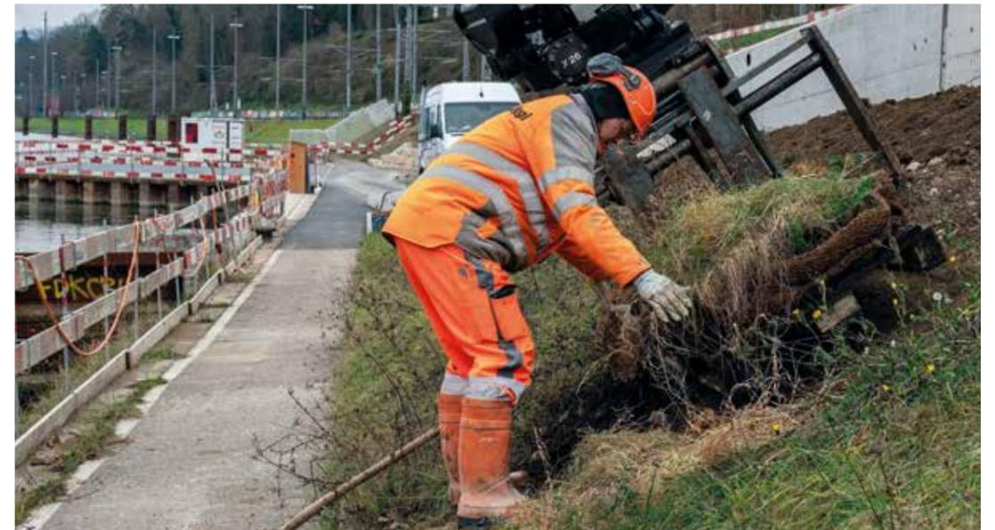
erfuhr der **Naturschutz** eine **weitgehende Rücksichtnahme**. Möglichst naturnah wurde der Mittelstreifen mit **Rasengitterwaben** gestaltet, die analog zur Uferböschung mit Magerwiese eingesät wurden. So wurde der Bewuchs der bestehenden Uferböschung im Februar abgeschält, die Grassoden auf Paletten zwischengelagert und über das ganze Jahr gepflegt und be-
