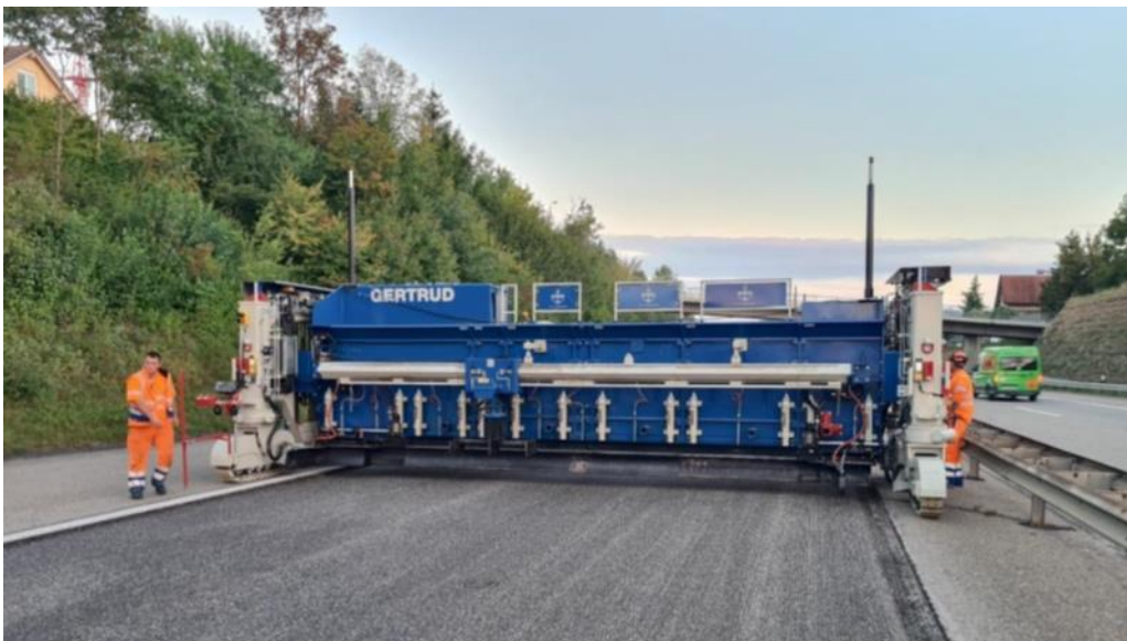
Abbildung 4: Gussasphaltfertiger auf offener Strecke
