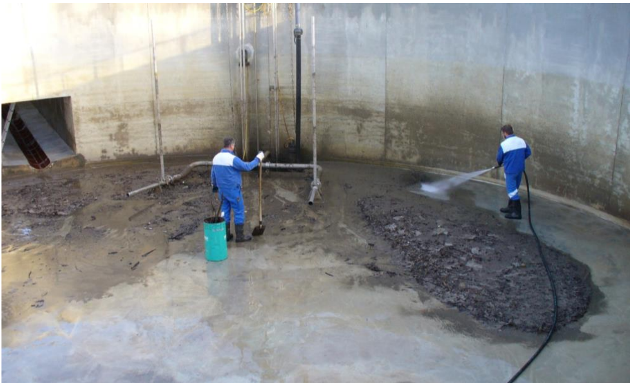
Abbildung 1: MWB Biel-Benken: Reinigung des Beckens nach Airjet-Ausfall
