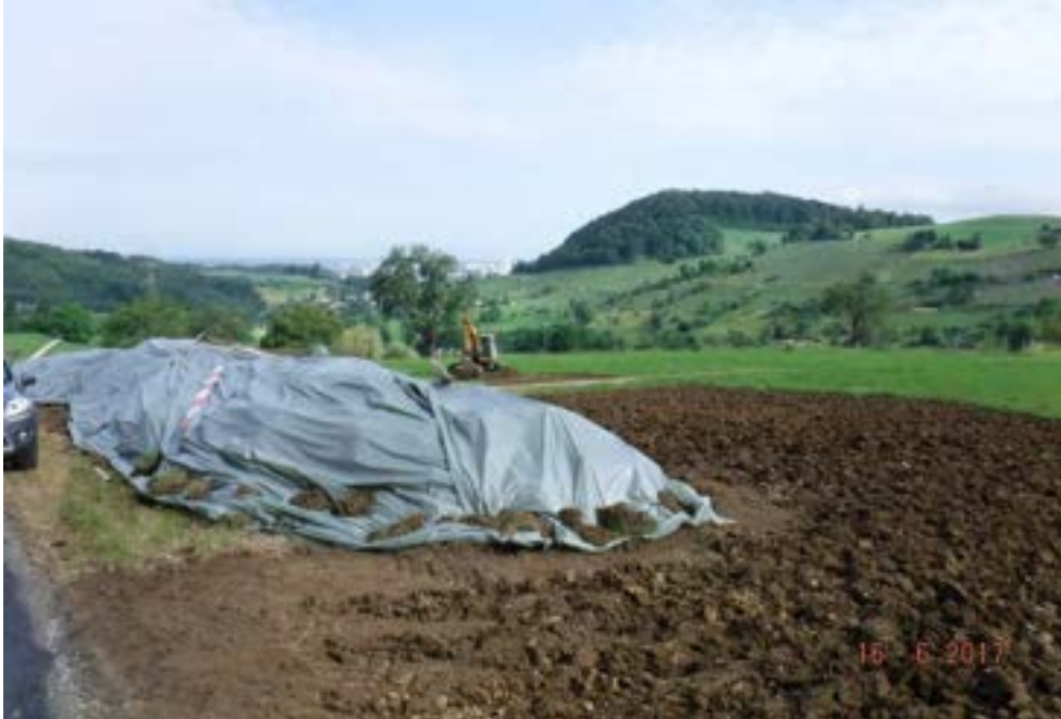
Abbildung 11: Abhumusierungsarbeiten und Zwischenlagerung des abgetragenen Bodenmaterials [4].
