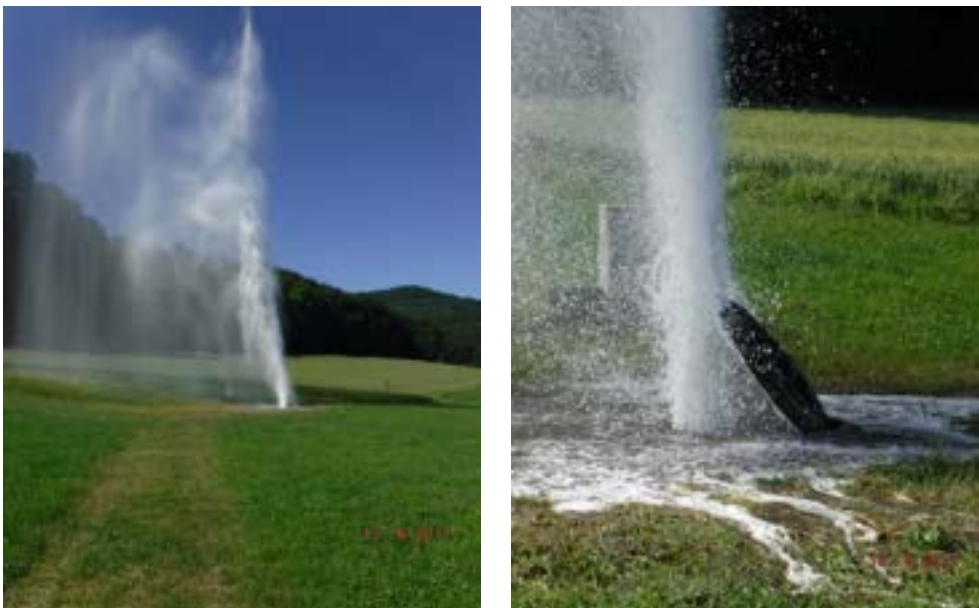
Abbildung 8: Fontäneartiger Soleaustritt aus S87 vor Beschwerung des Schachtdeckels [3].
