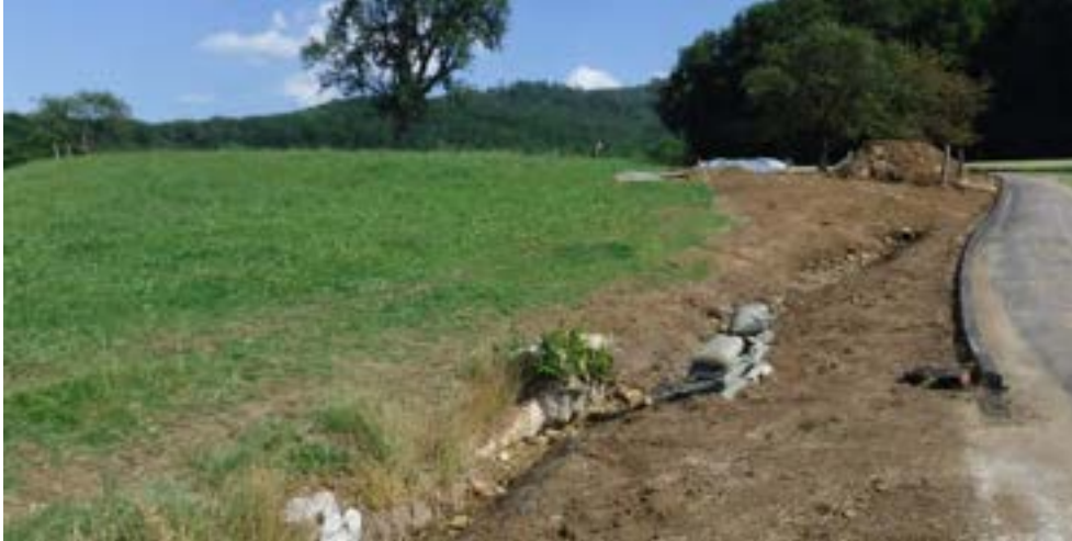
Abbildung 13: Graben und Belagskeil unterhalb S87 sechs Tage nach dem Ereignis. Über den Graben und mit dem Keil wurde die ausgetretene Sole kanalisiert.
