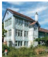
S151 MAISPRACH, ALTE FABRIK
