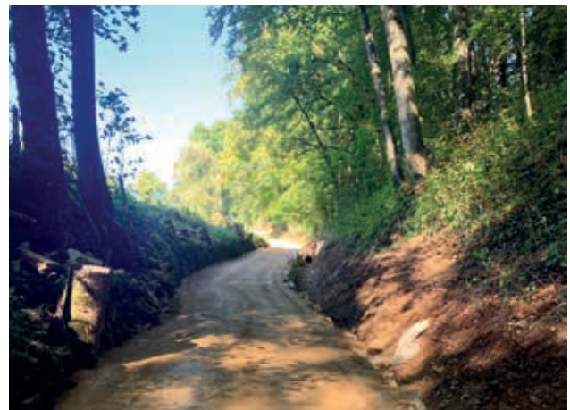
Instandstellung der Hochwasserschäden 2021: Die Arbeiten wurden in enger Zusammenarbeit mit den betroffenen Landeigentümern und Einwohnergemeinden geplant und umgesetzt.
