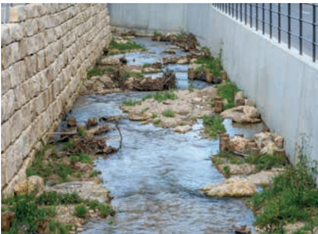
Die Arbeiten am Strassen- und Hochwasserschutzprojekt an der Hinteren Frenke in Reigoldswil kommen gut voran. Ein Grossteil der Gewässerkorrektur ist abgeschlossen; es fehlen nur noch die letzten 100 Meter des Bachausbaus.
