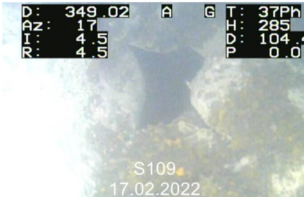
Abbildung 8: Videoaufnahme (axial nach unten, unterhalb des Rohrschuhs) vom 17.02.2022 der Produktionsbohrung S109 in einer Teufe von 349 m. Es sind lose Blöcke zu erkennen, woraus sich ein Teilverbruch der ursprünglichen Kaverne ableiten lässt. Der unterste Teil der LZRT ist abgerissen. Bohrlochaufnahme: Terratec Geophysical Services.
