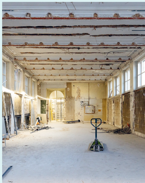
Rückbauarbeiten im Gebäude der Alten Gewerbeschule, hier im künftigen Lesesaal der neuen Bibliothek.
