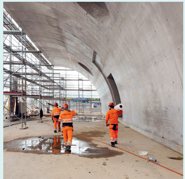
Die prägnante Auskerbung der Stirnfassade des Gebäudes ist bereits gut erkennbar.
