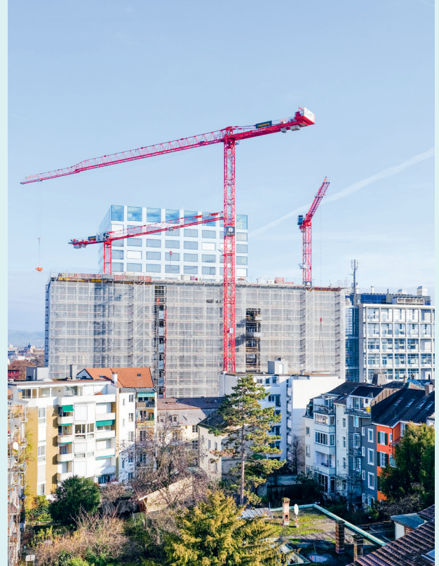
Der Rohbau des neuen Departements Biomedizin konnte im Dezember fertiggestellt werden.
