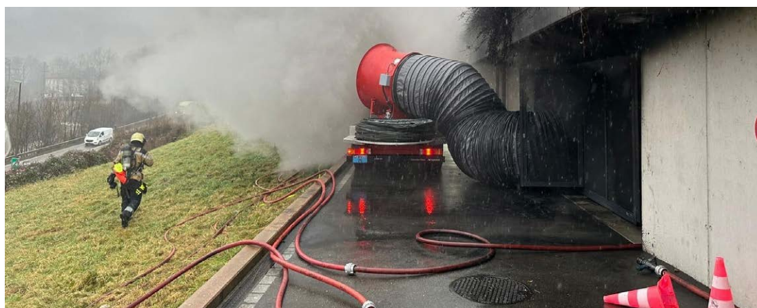
Brand Autoeinstellhalle in Aesch, 18.01.2024
