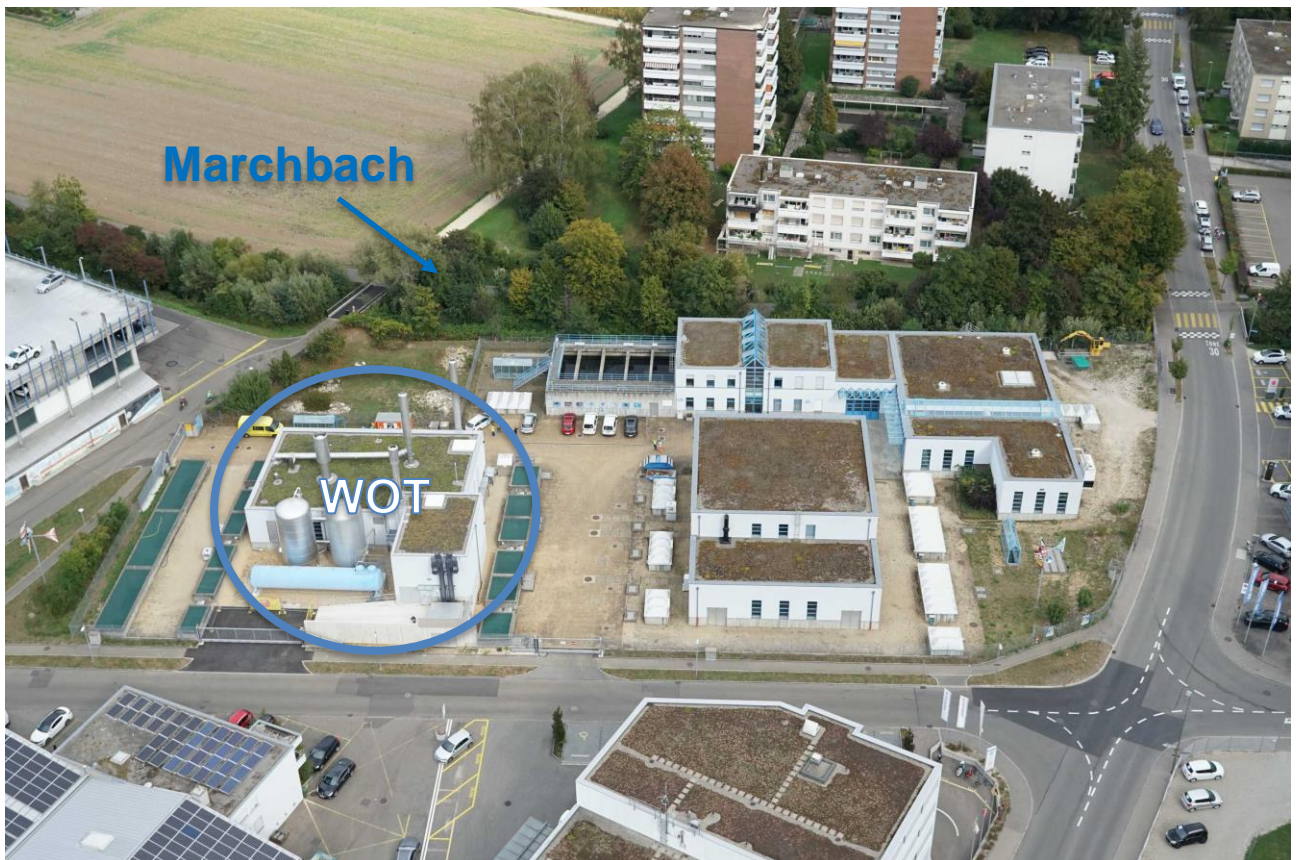
Abb. 1: Übersicht ARA Birsig in Therwil (Bau 1994-1997) und Wärmeverbund Oberwil-Therwil (WOT, Erweiterung 2019). Die Klärbecken erstrecken sich über die gesamte Parzellenfläche unterhalb des Terrains respektive unterhalb der Gebäude.
