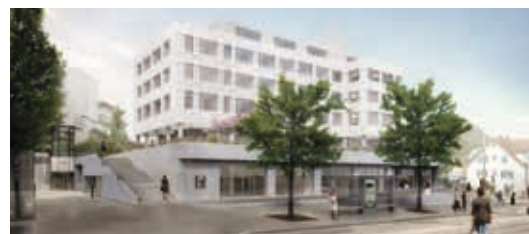
Künftige Liegenschaft an der Hauptstrasse 34 in Binningen nach dem Umbau. Visualisierung: Proplaning AG Basel.
