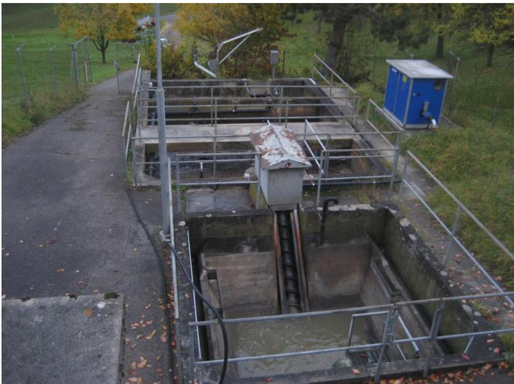
Abbildung 1: ARA Nussdorf, Hebewerk mit Belebungs- und Nachklärbecken. Baujahr 1968.
