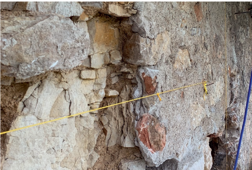
Schildmauer, Aussenseite: Nach dem Entfernen einer dünnen Vormauerung (rechts, ca. 1950) kamen auch hier vom Frost zerstörte mittelalterliche Mauersteine zum Vorschein, die ersetzt werden mussten.
