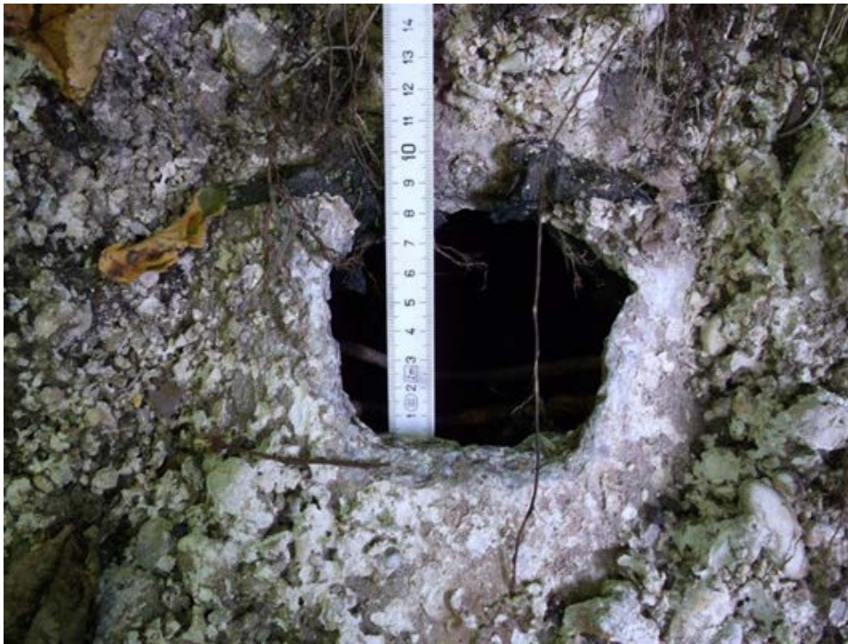
Abbildung 2: Löcher durch Abrasion im sehr steilen Kanal AIB
