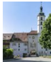
S247 LAUFEN, RINGMAUER
