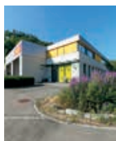
S 123 EPTINGEN BLT DEPOT UND GARAGE
