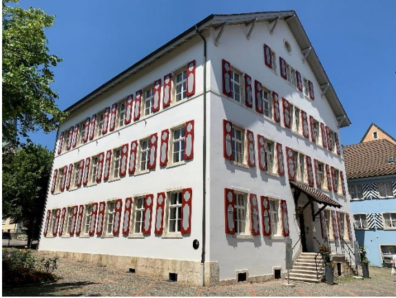
Laufen, Stadthaus, Sanierung und Fensterersatz
