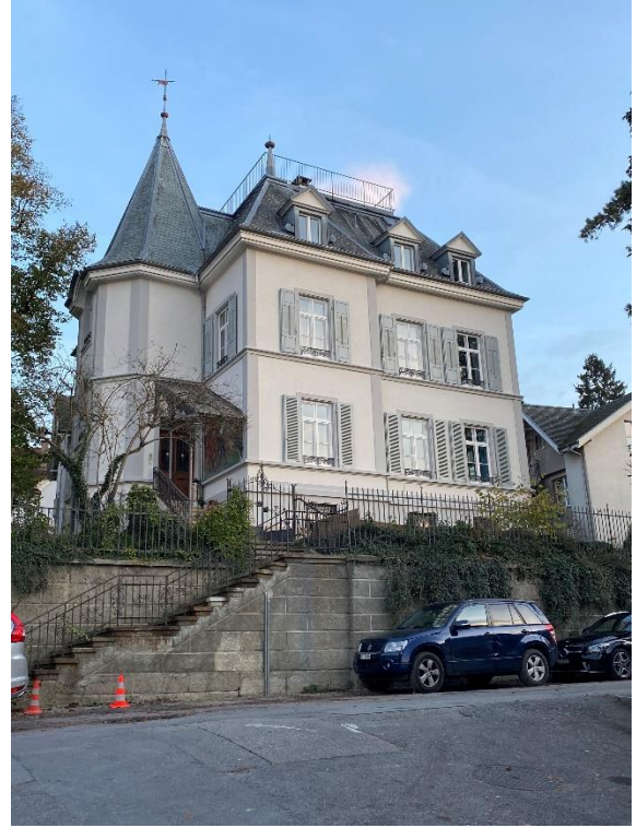
Liestal, Gartenstrasse 2, Aussensanierung
