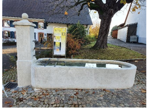
Rünenberg, Dorfbrunnen Mitteldorf, Sanierung
