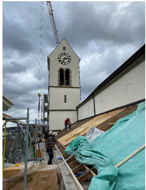
Oberwil, Katholische Kirche, Dachsanierung
