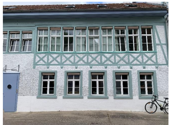
Maisprach, Alte Fabrik, Aussensanierung
