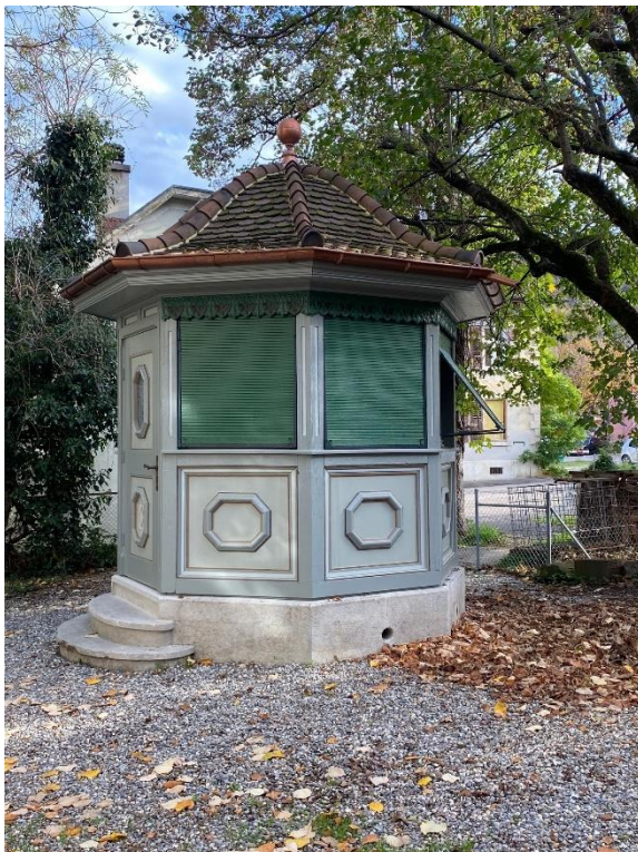
Sissach, Cheesmeyer Pavillon, Sanierung
