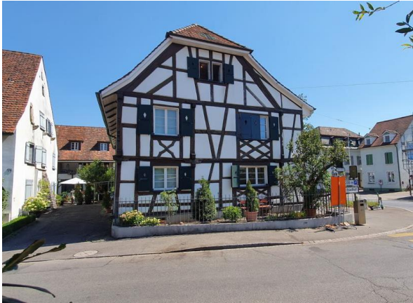
Allschwil, Baslerstrasse 27, Fassadensanierung
