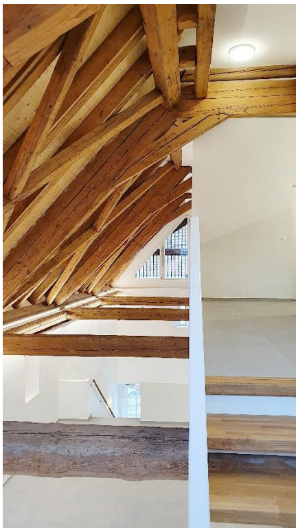
Augst, Hauptstrasse 25, Scheunenumbau
