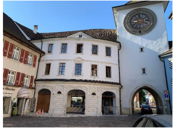
Laufen, Rathaus, Fassadensanierung
