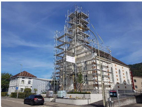
Liestal, Methodistenkapelle, Restaurierung Turm
