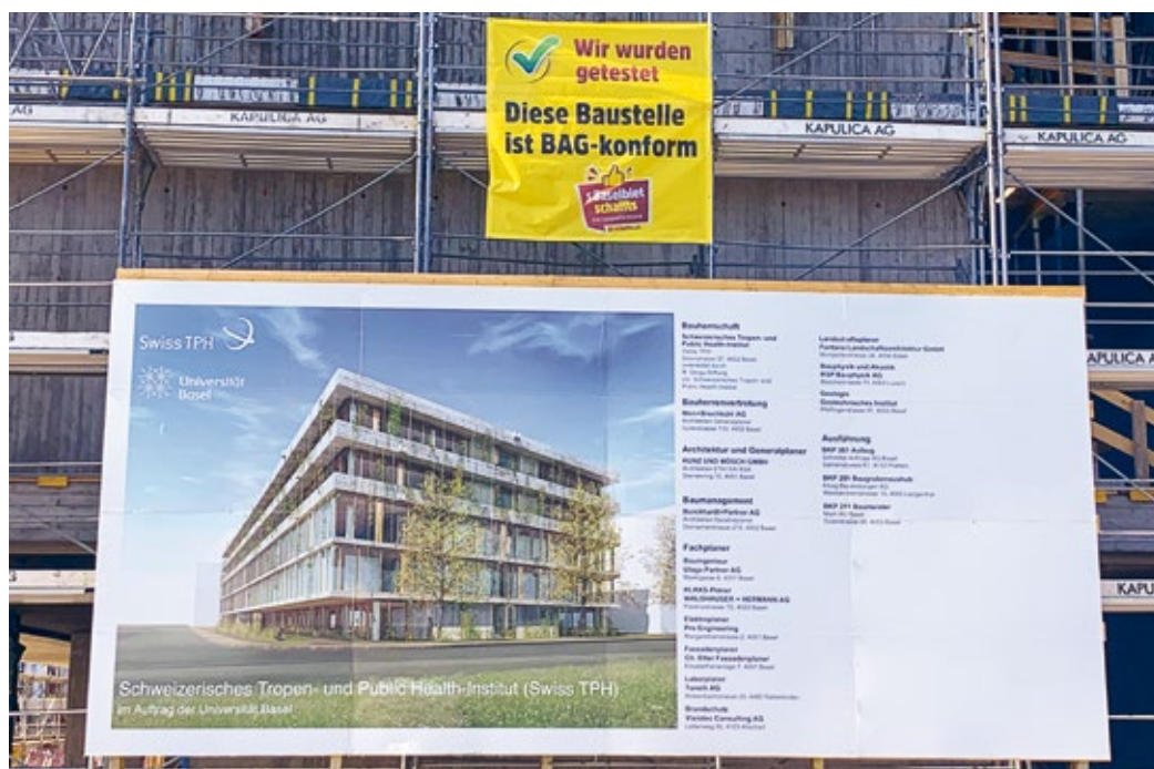
→ Baustelle des neuen Swiss TPH-Gebäudes "Belo Horizonte", konform mit den Standards des Bundesamtes für Gesundheit.
