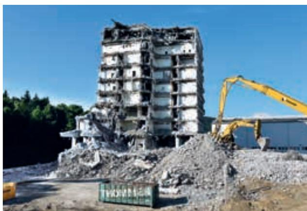
Durch die Trennung der Bauabfälle und deren Aufbereitung in Verwertungs- und Aushubwaschanlagen lassen sich diese Abfallstoffe zu hochwertigen Recycling-Baustoffen aufbereiten. Diese können dann in der Bauwirtschaft als Ressourcen eingesetzt werden. Dadurch werden wertvolle Primärrohstoffe eingespart und knapper Deponieraum wird geschont.
