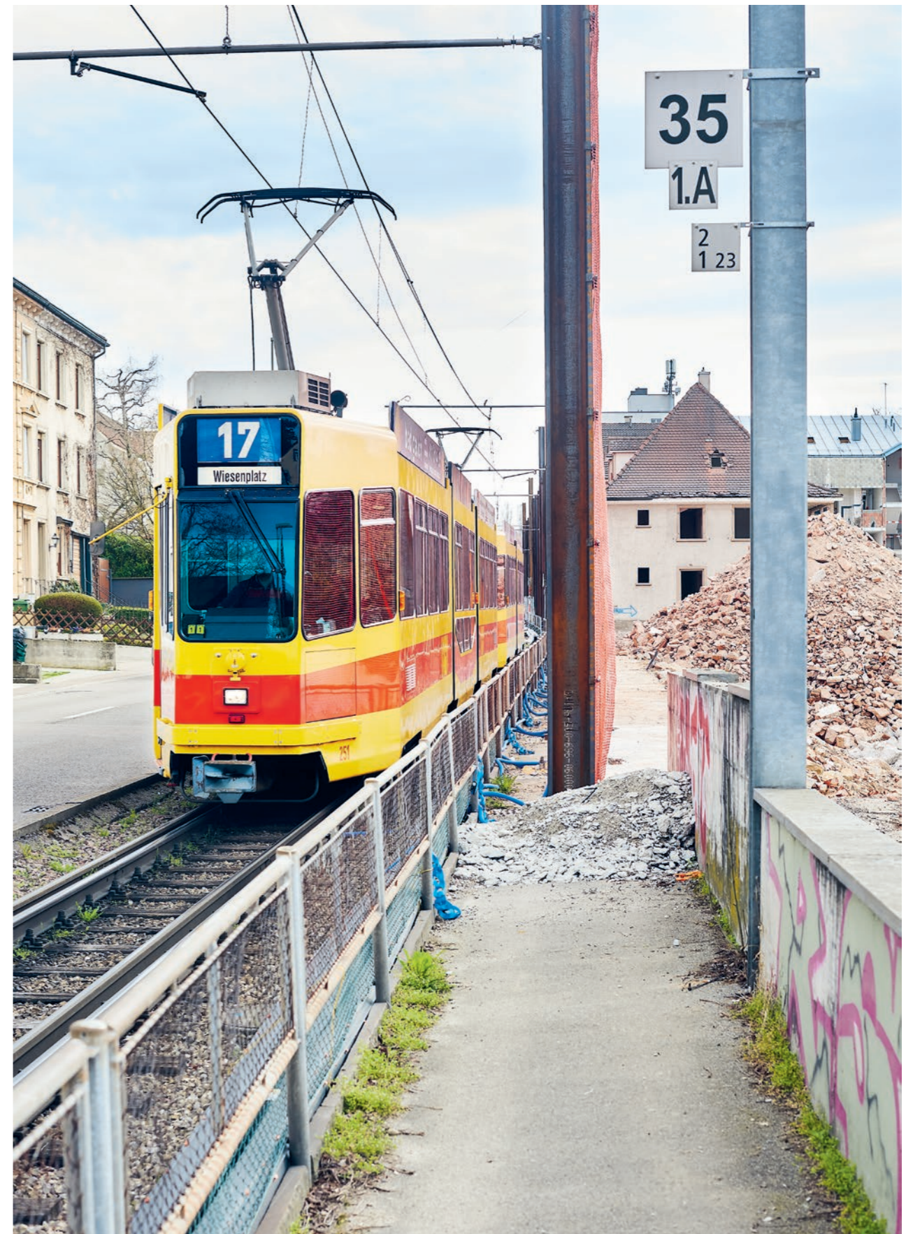
Rückbau der Liegenschaften für den bewilligten Doppelspurausbau Spiesshöfli.
