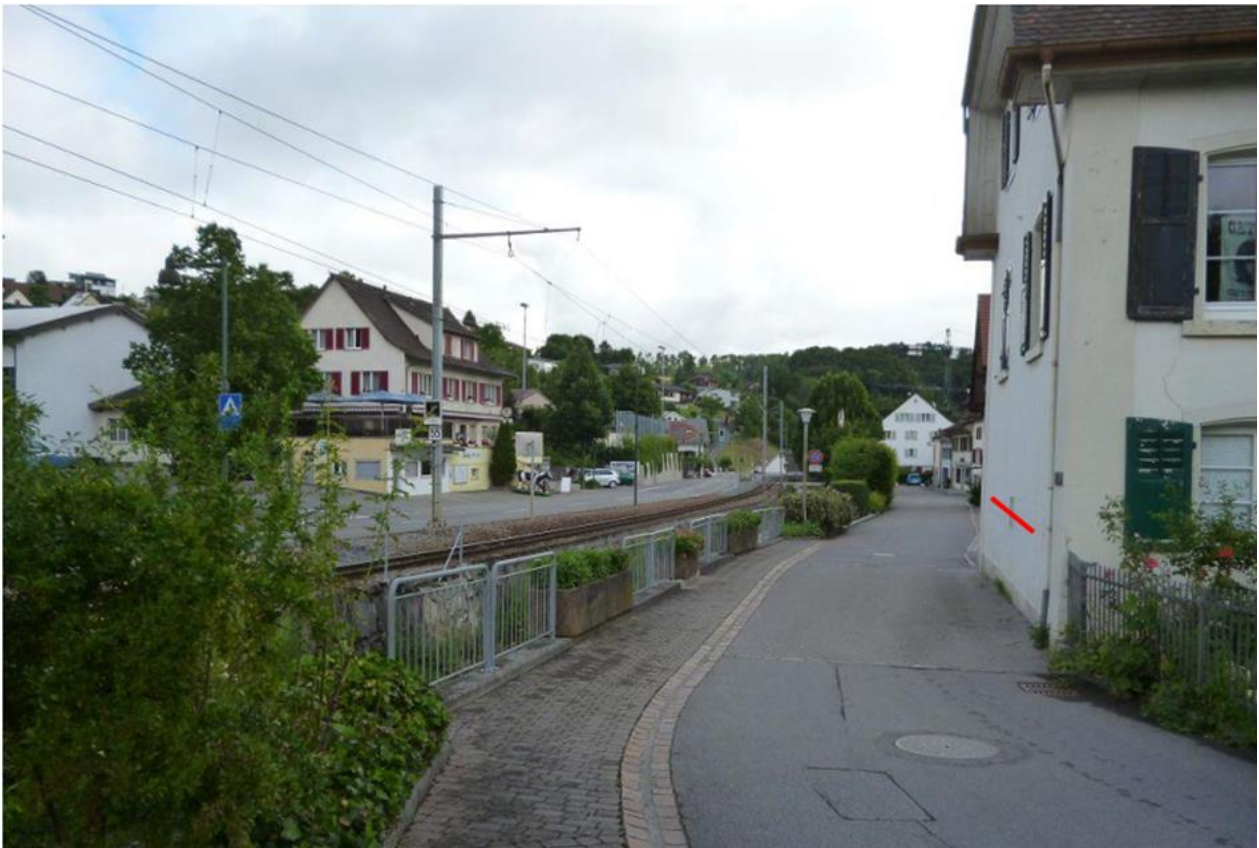
Abbildung 1: Engstelle Dorf-gasse 40. An der Hauswand ist eine Hochwasser-marke von Hochwasser 16. Juli 1830 erkennbar und rot gekennzeichnet. Blick in Fliessrichtung
