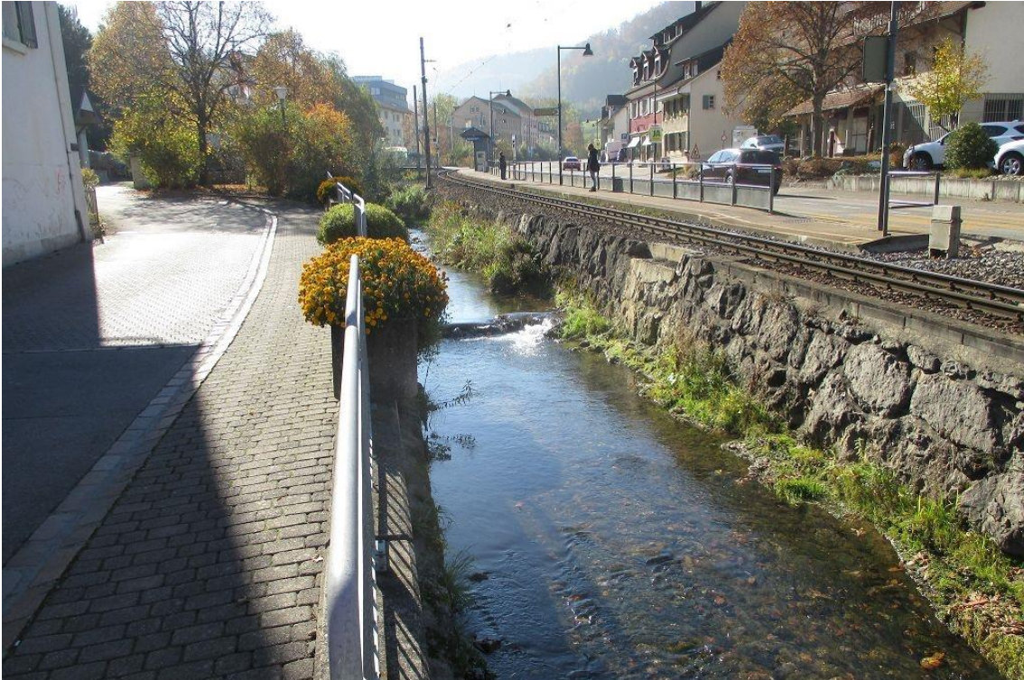
Abbildung 3: IST-Zustand Vordere Frenke an der Engstelle Dorfstrasse 40, Blick gegen Fliessrichtung
