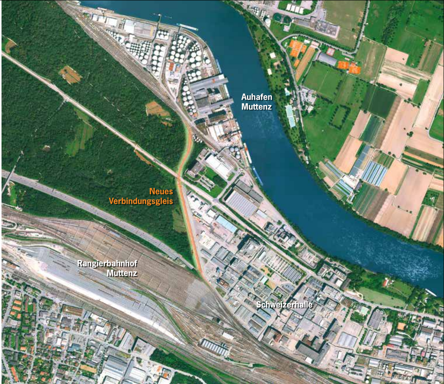
Das neue Verbindungsgleis zwischen dem Auhafen und dem Rangierbahnhof Muttenz
