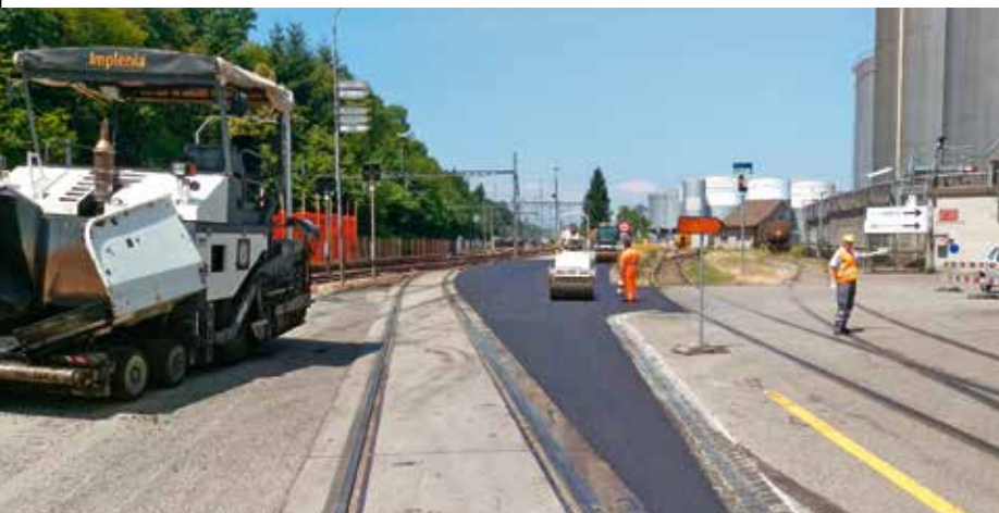
Belagsarbeiten Auhafenstrasse Muttenz abgeschlossen
