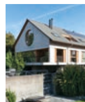
S 261 MUTTENZ MEHRFAMILIEN- HAUS VON FELIPPI WYSSEN ARCHITEKTEN
