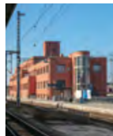
S189 SBB, BAHNGEBÄUDE, MUTTENZ
