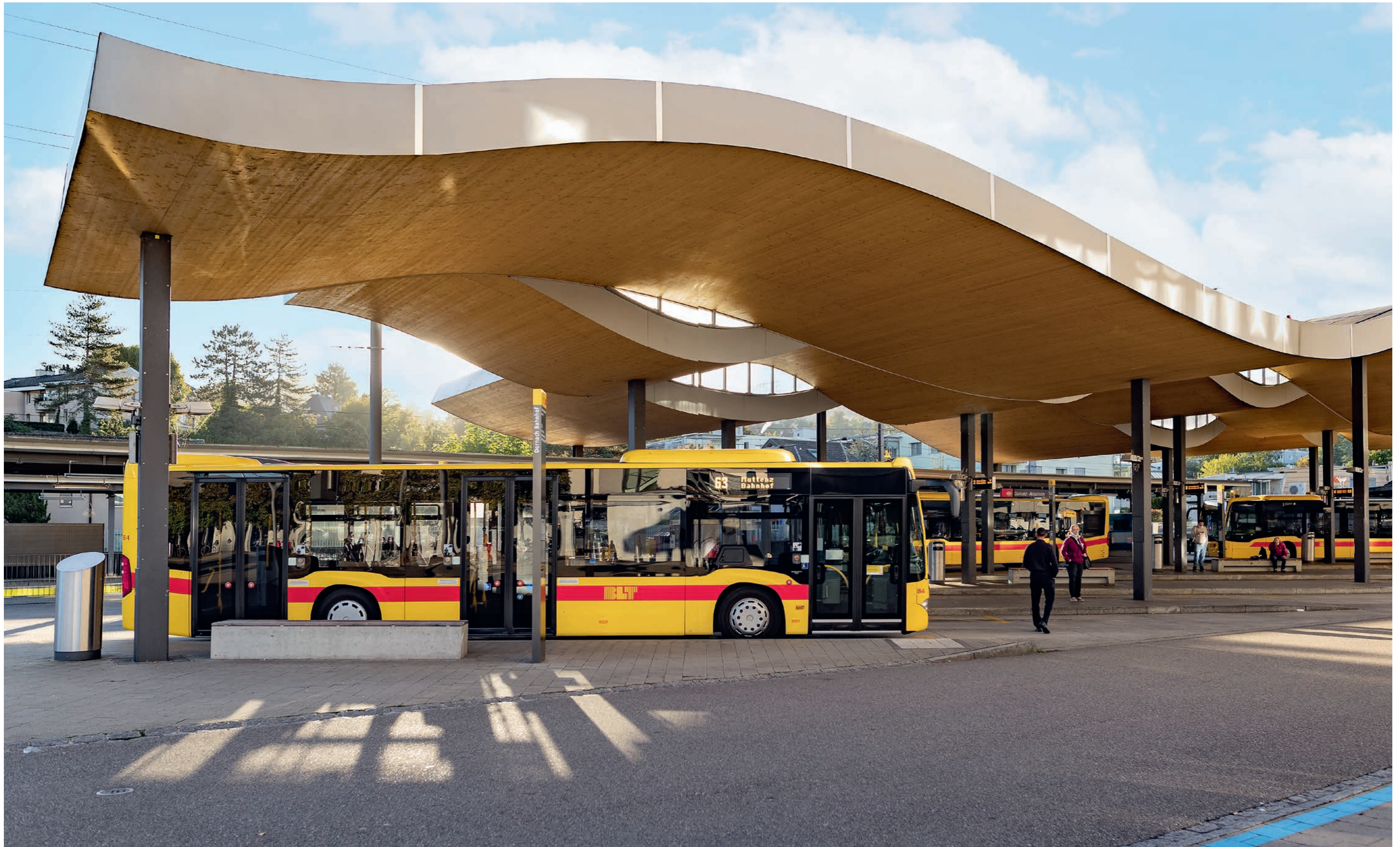
Bahnhof Dornach – die regionale Verkehrsdrehscheibe mit Bus-, Tram- und S-Bahnanschluss.
