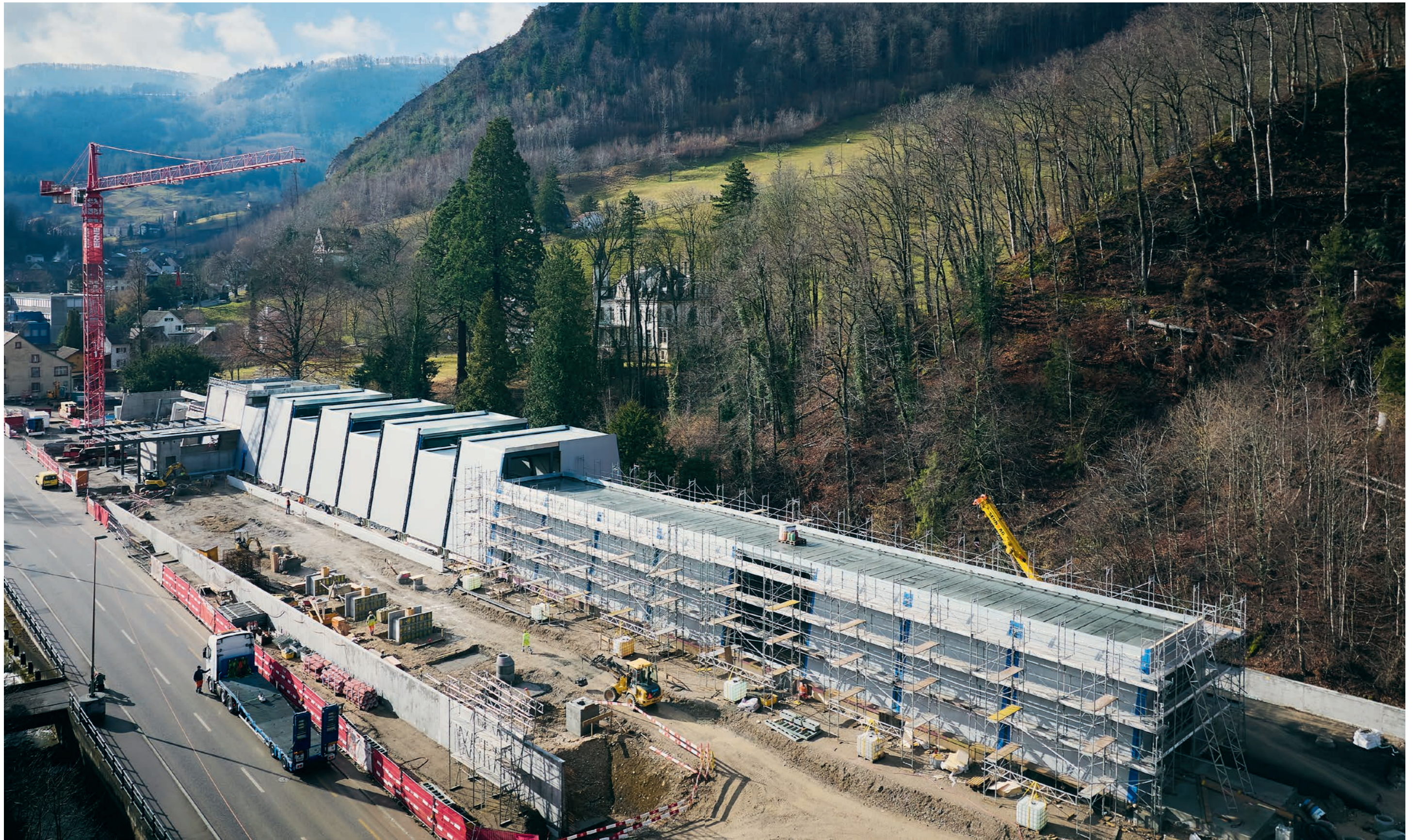
Der neue Bahnhof Waldenburg im Bau – Blick auf das Depot mit Fahrzeugunterhaltshalle, Waschanlage und Werkstatt.
