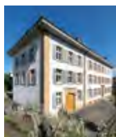
S91 ALLSCHWIL, GEMEINDE- SCHULHAUS
