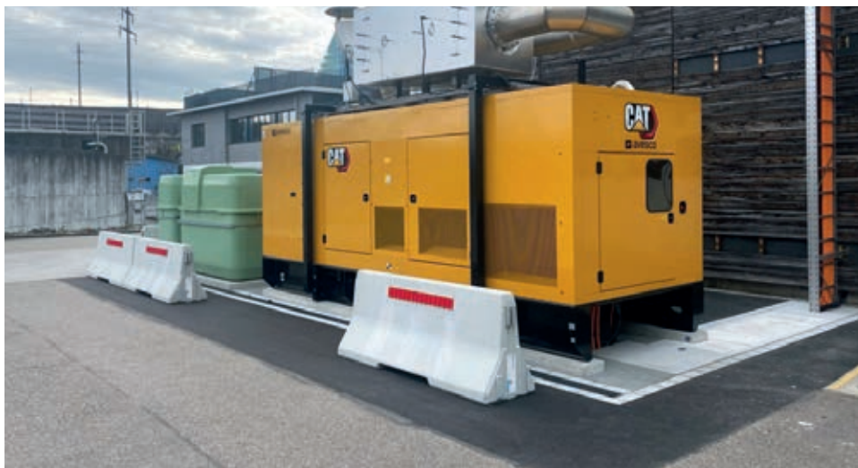
Notstromaggregat auf der ARA Birs.
