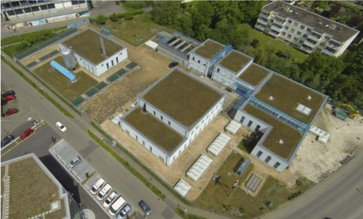
Abb. 1: Übersicht ARA Birsig in Therwil (1994-1997). Die Klärbecken erstrecken sich über die gesamte Parzellenfläche unterhalb der Gebäude. Das Mischwasser- und Havariebecken liegt unterhalb des BLT-Depots (links-oben im Bild).
