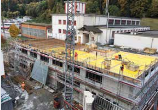
Im Dezember 2016 war der Rohbau des neuen Schulungsgebäudes vollendet.
