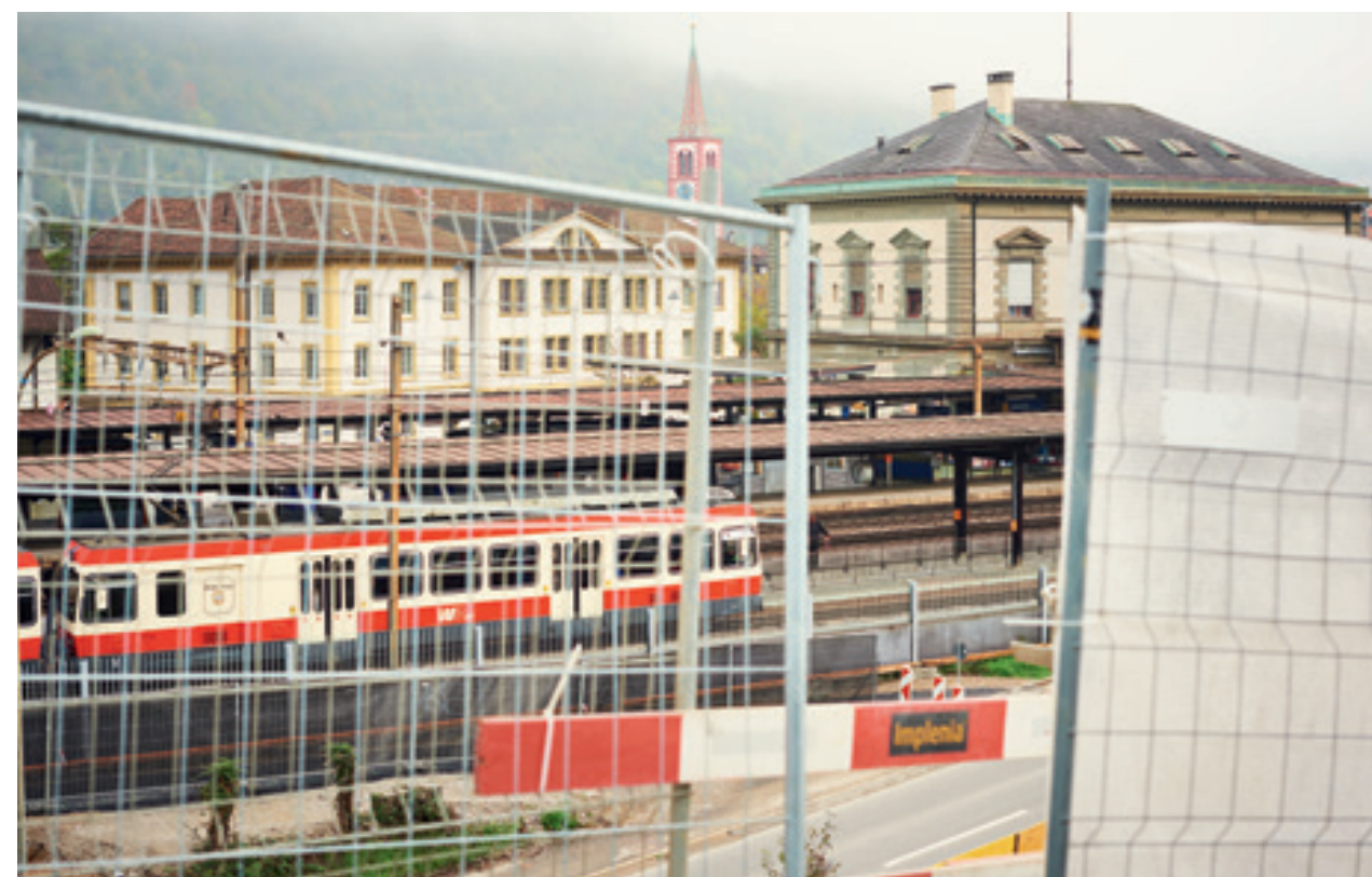
Der Vierspurausbau im Bahnhof Liestal läutet die Bauphase zur Erneuerung der Waldenburgerbahn ein.
