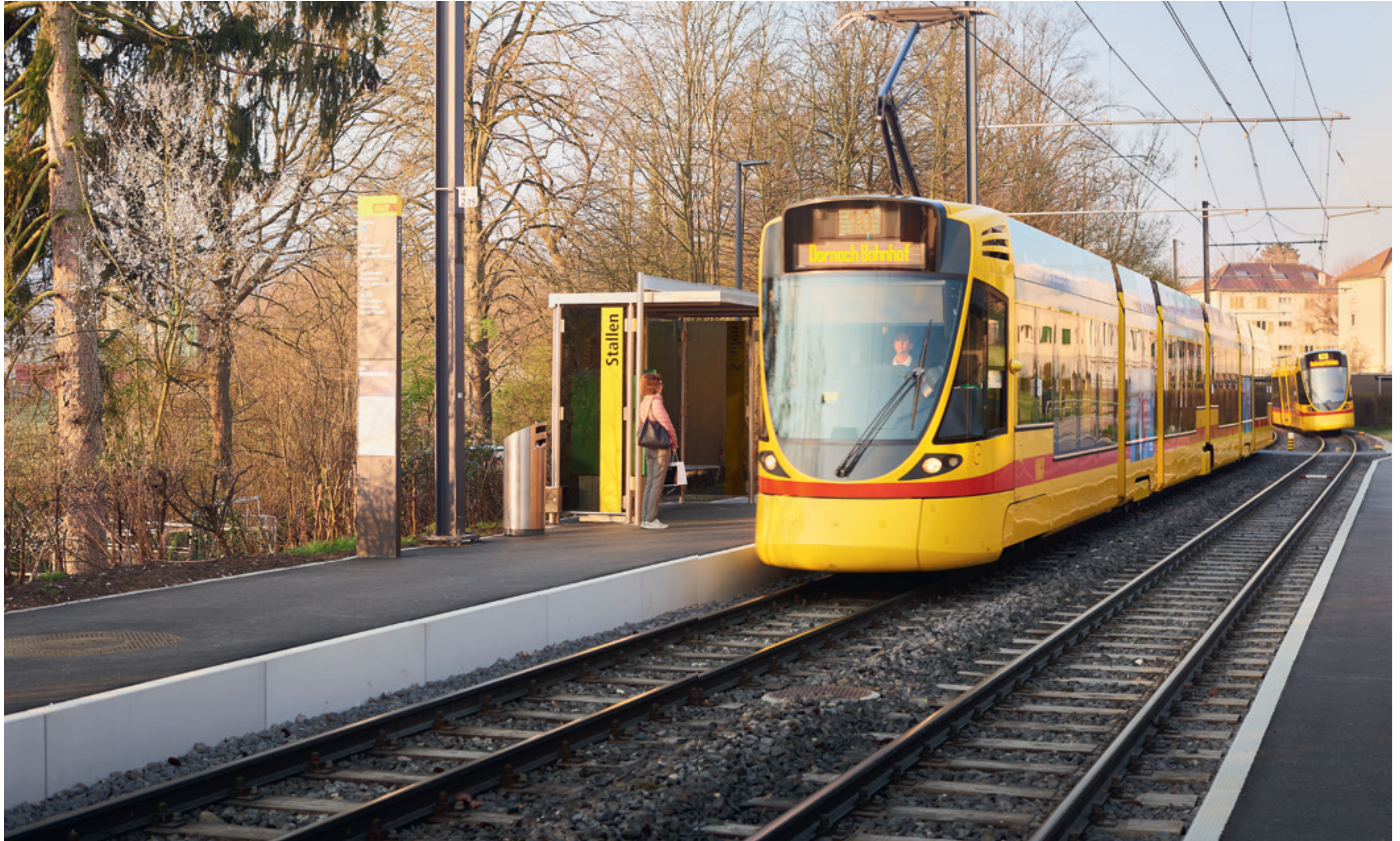
Die BLT baut alle Tramhaltestellen hindernisfrei um, gemäss den Anforderungen des Behindertengleichstellungsgesetzes.
