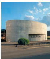
S 181 LAUFEN KERAMIK FORUM SHOWROOM NISSEN WENTZLAFF ARCHITEKTEN
