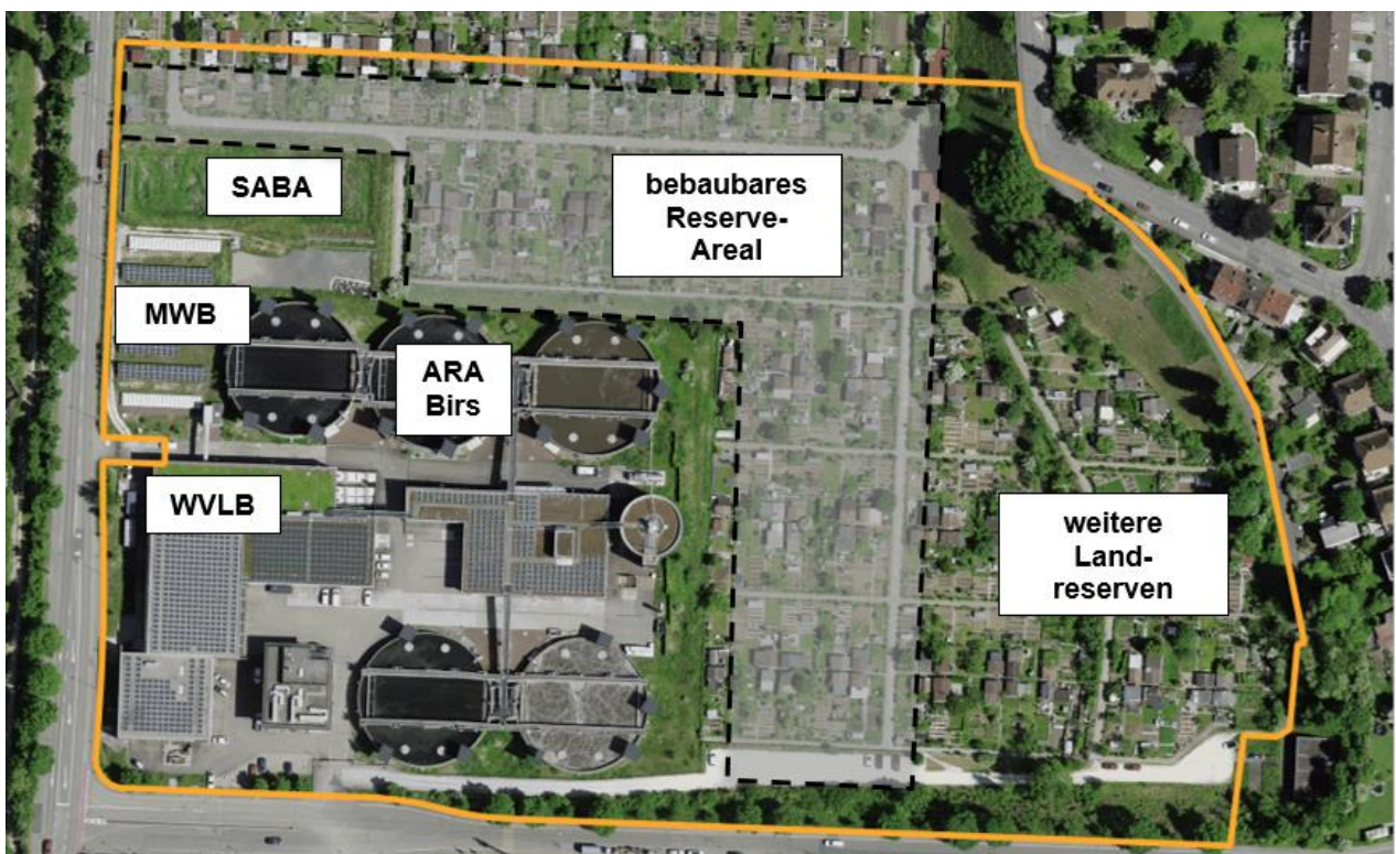
Abb. 1: Heutige ARA Birs (Freulerstrasse 1, 4127 Birsfelden) mit Parzellengrenze (orange) und bebaubarem Reserveareal (grau, schwarz gestrichelt umrandet). Ebenfalls auf dem Areal befindet sich der Wärmeverbund Lehenmatt Birs AG (WVLB), die Strassenabwasserbehandlungsanlage (SABA) der A2 (ASTRA) sowie ein Mischwasserbecken (MWB).
